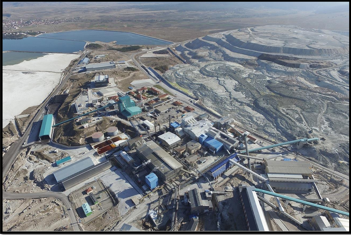
Şekil 8. Kırka (Eskişehir) Eti Bor Madeni İşletmesi Müdürlüğü yerleşkesi. Tesis, Kırka'nın 4.5 Km batısındadır. 1984 yılında beri faaliyetini sürdürmektedir.
