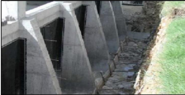
Resim 3. Betonarme nervürlü istinat duvarı
