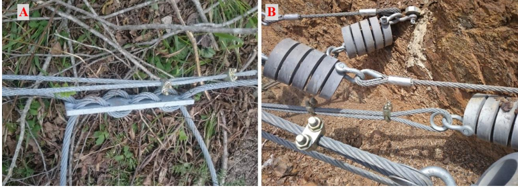
Şekil 1. Farklı 2 tipte sönümleyici. (A) Trabzon Maçka İlçesinde (B) Artvin Ardanuç İlçesinde yapılan kaya ıslahı çalışmalarında çekilmiştir.
