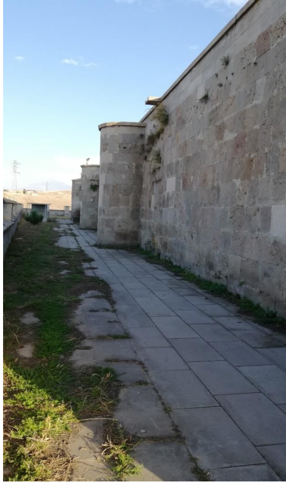
Sağ ve Sol Yan Duvar Görüntüsü
