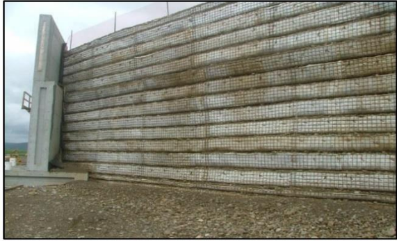
Resim 5. Geotekstil örtü donatılı istinat duvarı
