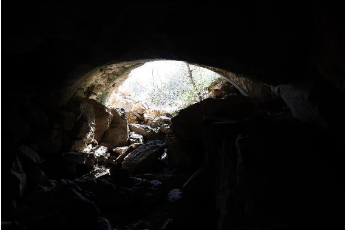
Foto. 9) Basamaklı Tünel İçten Görünüm
