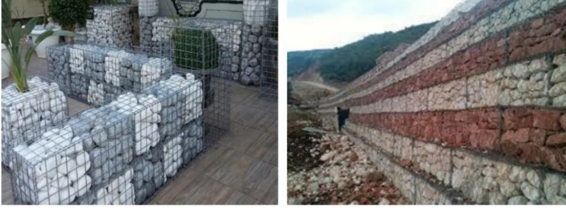
Resim 6. Gabion istinat duvarı
