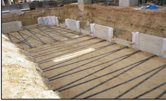
Resim 4. Mekanik şerit donatılı istinat duvarı
