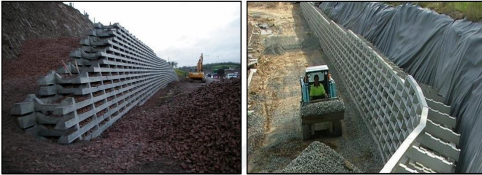
Resim 7. Kafes istinat duvarı
