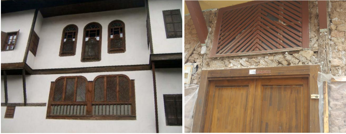
Şekil 10: (sol) Gökçüoğlu Bağ Evi muşabaklı pencereler, (sağ) giriş kapısı önü ahşap kafes, Osmaneli, 2018 (Yazar arşivinden)
